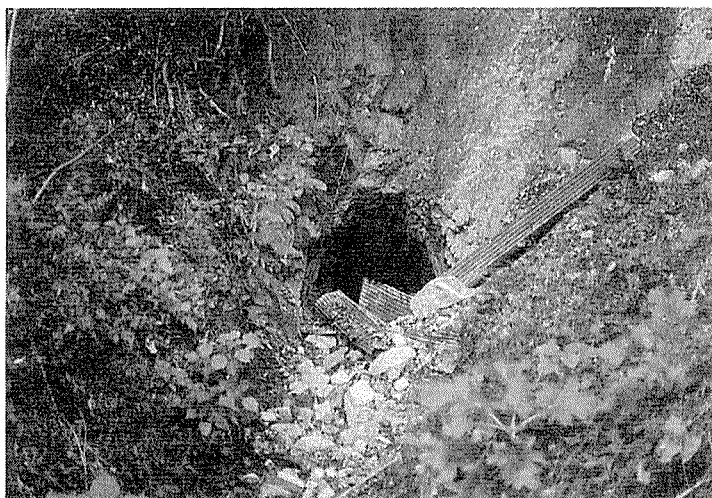
写真1. 旧導水トンネルの入口
