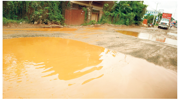
図3 首都郊外でも道路は舗装がなく陥没し雨期には通過が困難となる
