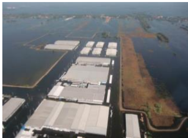
写真 1.2 ユタヤ・ロジアナ工業団地の状況
