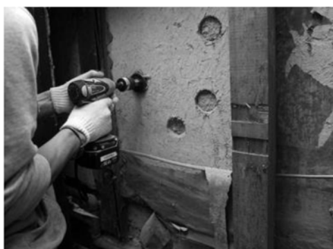
図 6-5 土塗壁のコア抜き
