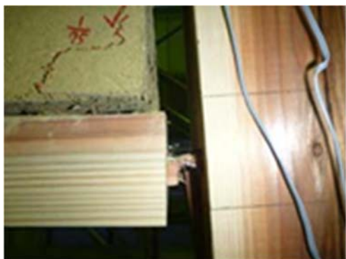
(a)引抜け圧縮破壊 (A-1 試験体 1/30rad 時)
