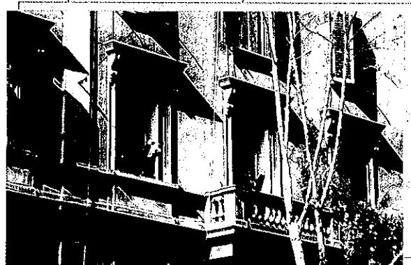
緻密な建物改修
