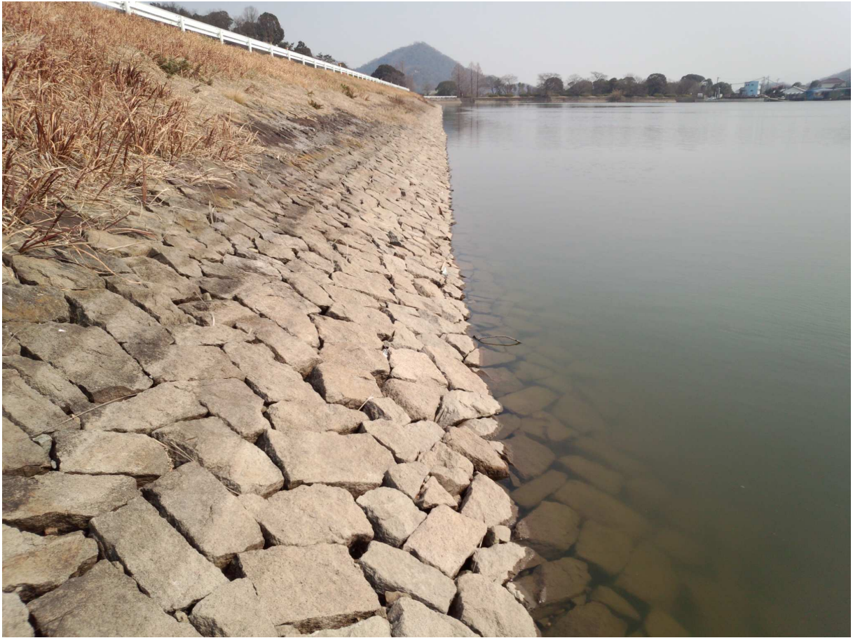
写真-3.2 平池の周辺状況（堤体の内側護岸ブロックを撮影）
