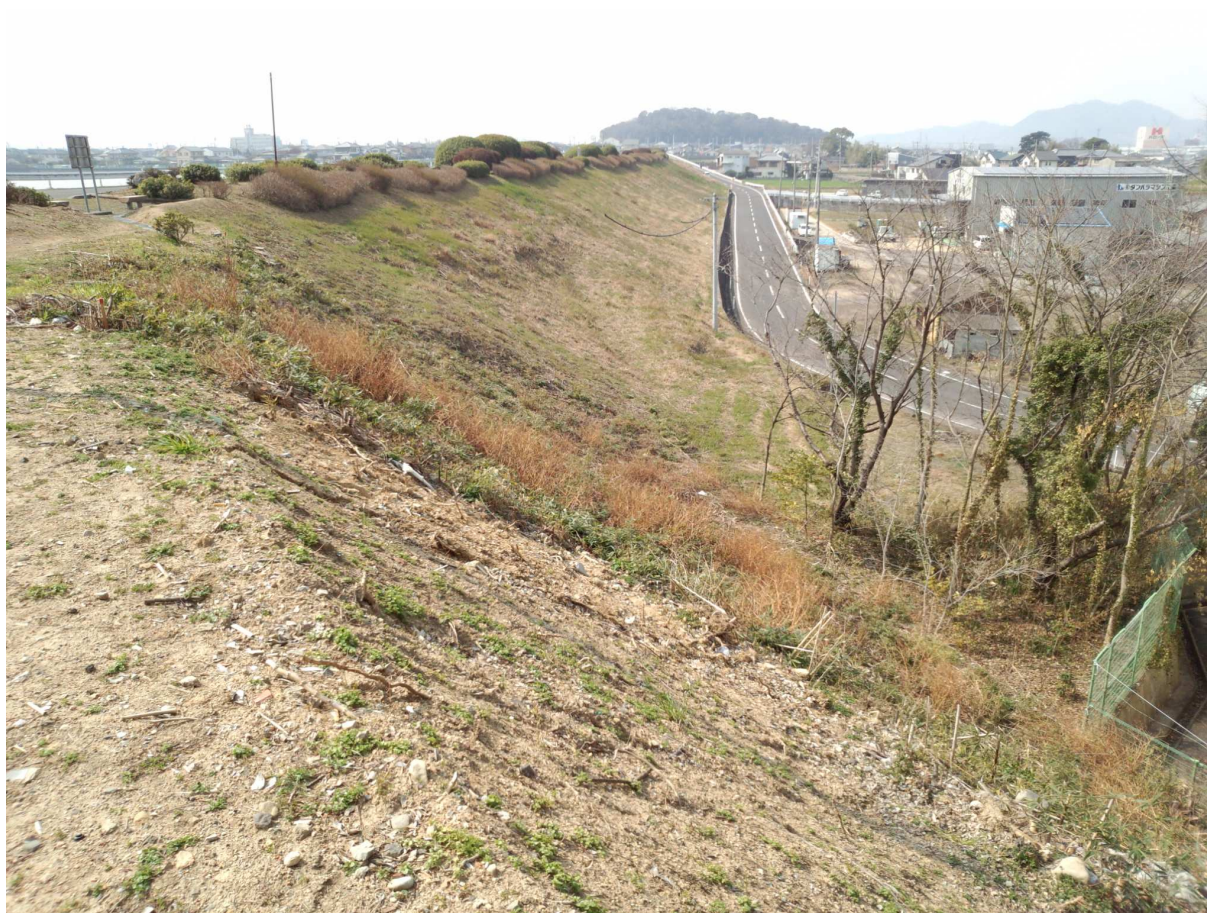
写真-3.1 平池の周辺状況（堤体頂部東端から西向きへ撮影）
