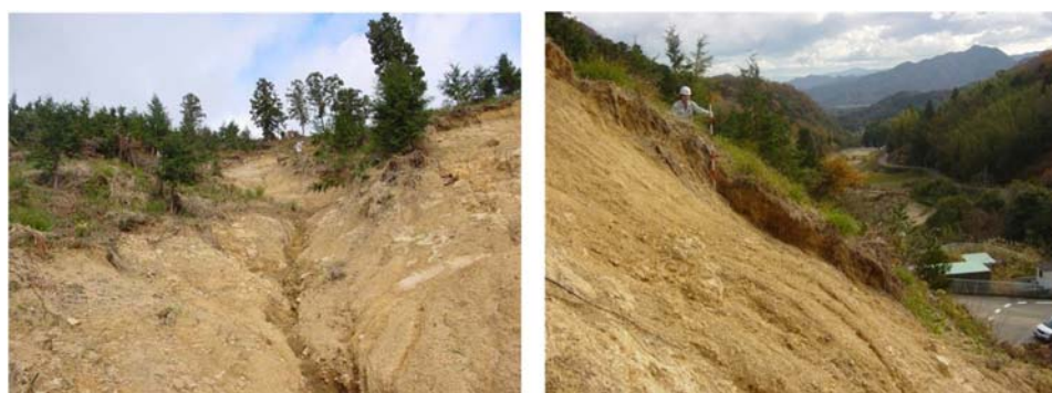
写真-6.1.4 さぬき市森行地区の崩壊斜面の状況
