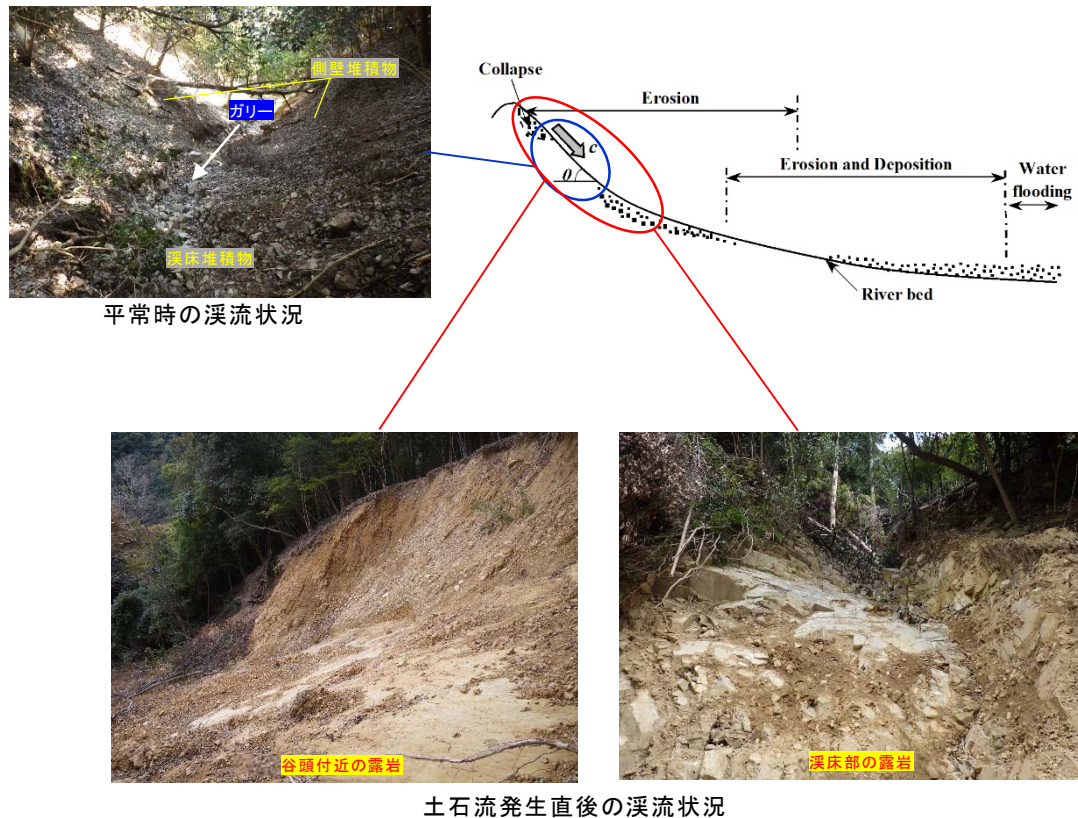
図-2.4.1 土石流発生直後の溪流状況の例
