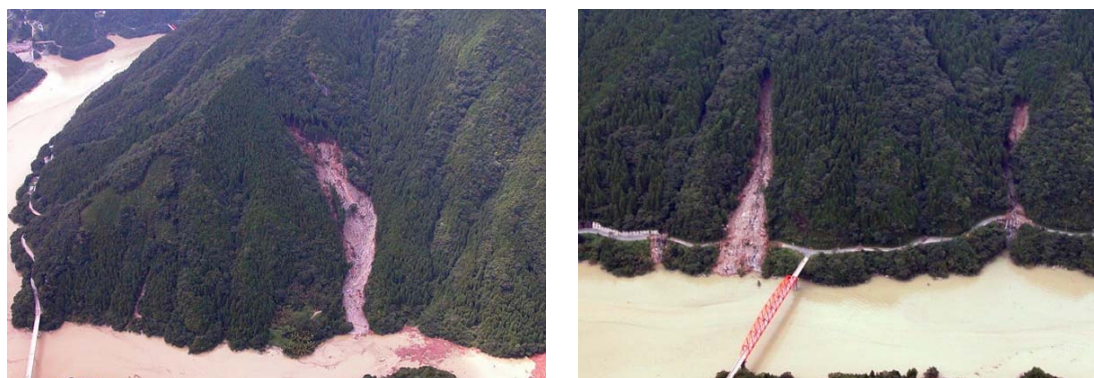
写真-6.1.2 早明浦ダム周辺の斜面崩壊状況(左:小松地区, 右:南川地区) (株式会社パスコ撮影)
