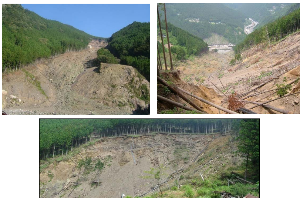
写真-6.1.1 阿津江地区で発生した斜面崩壊の状況
