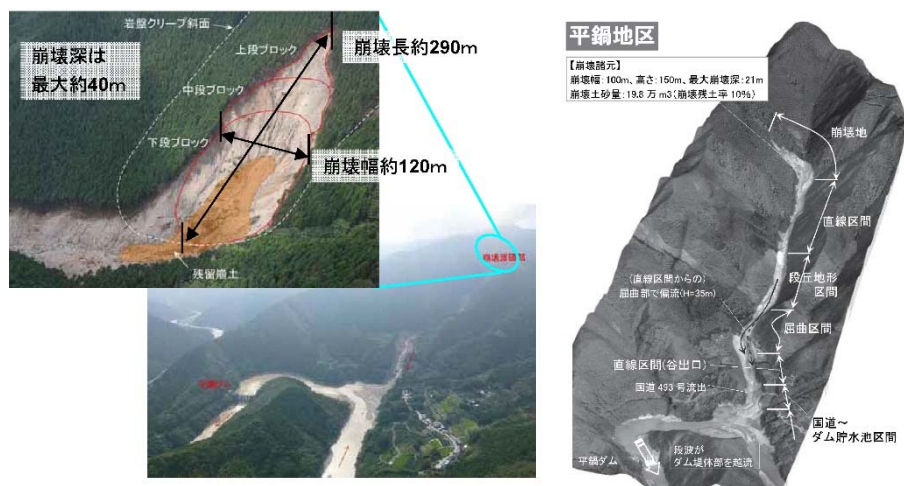
図-2.2.4 高知県奈半利川流域で発生した深層崩壊に起因した土石流災害 15)
