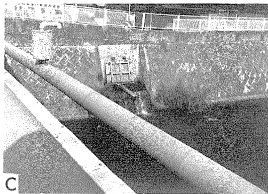
図2. 御坊川調査地の景観．A：ブロックで護岸された堤と、兩岸に生育する雑草（大栗橋より上流側）．B：上流側から見た大栗橋．C：常時下水が流下している所（向って右側が下流）．
